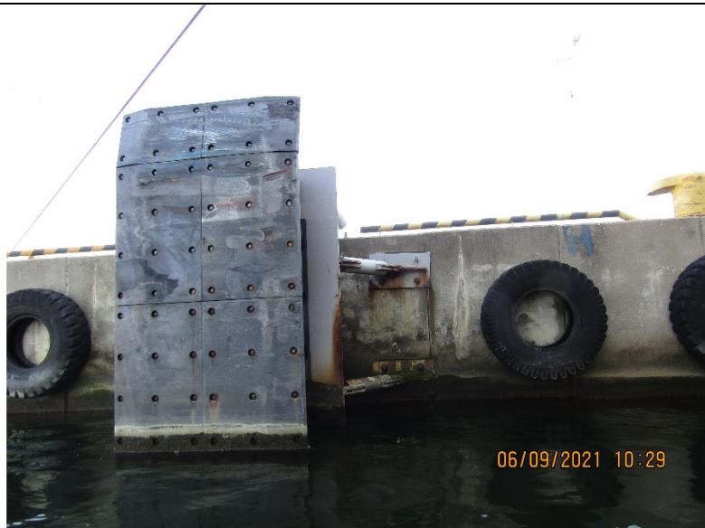
Fot. 28 – urządzenie odbojowe – widok od strony wody – korozja elementów stalowych na linii wahań zw.wody
