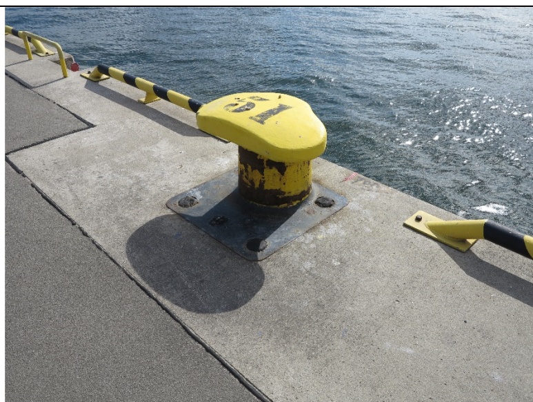
Fot. 15 – pachoł cumowniczy 51 – widoczne uszkodzenia powłoki malarskiej i korozja
