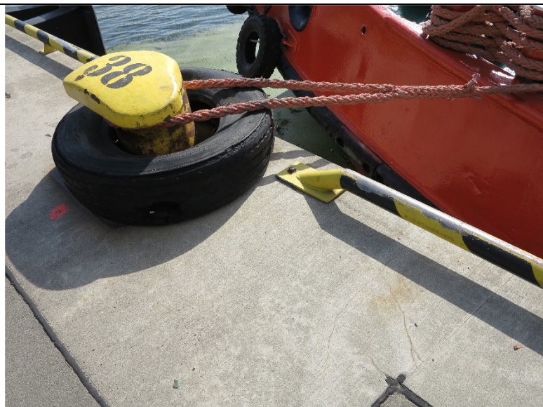
Fot. 10 – pachół cumowniczy pierwszej linii – lokalne uszkodzenia powłoki malarskiej oraz korozja; krawężnik ochronny stalowy – przetarcia powłoki malarskiej
