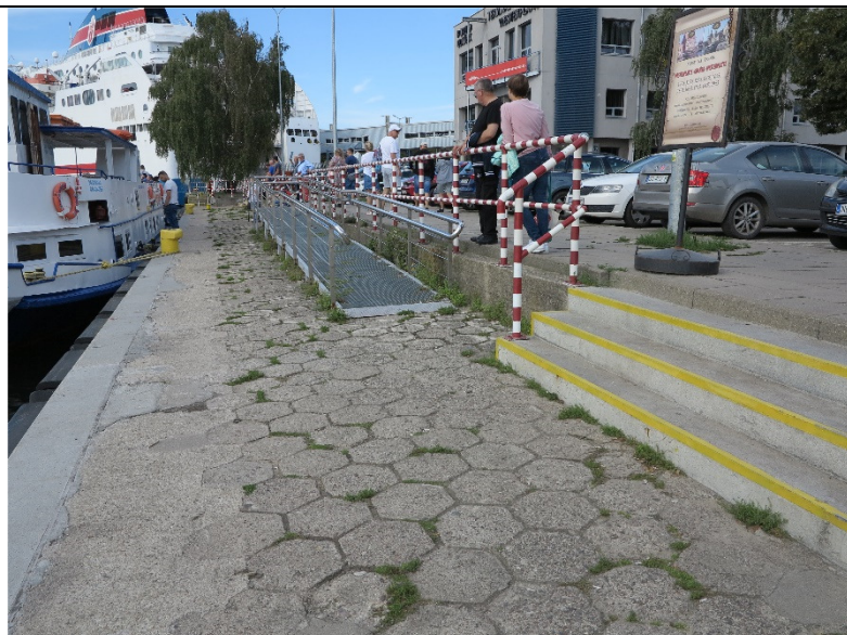
Fot. 25 – odc. 18-19 skorodowany i wykruszony beton wylewki za oczepem i płyt nawierzchni - trylinki
