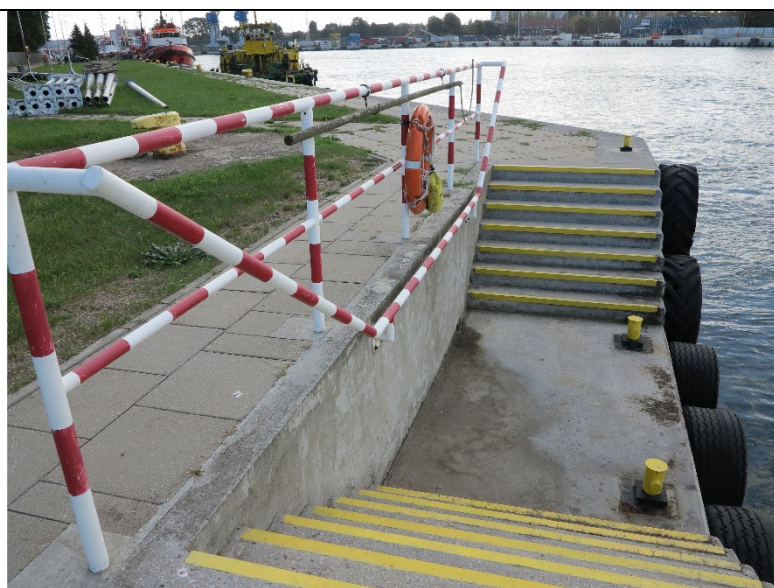
Fot. 2 – przystań niska dla motorówek – stan dobry – korozja podstawy pachoła cumowniczego
