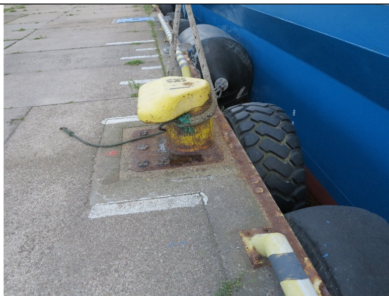
Fot. 21 – znaczna ubytki powłok malarskich na trzonie pachoła cumowniczego 81, korozja kątownika ochronnego stalowego
