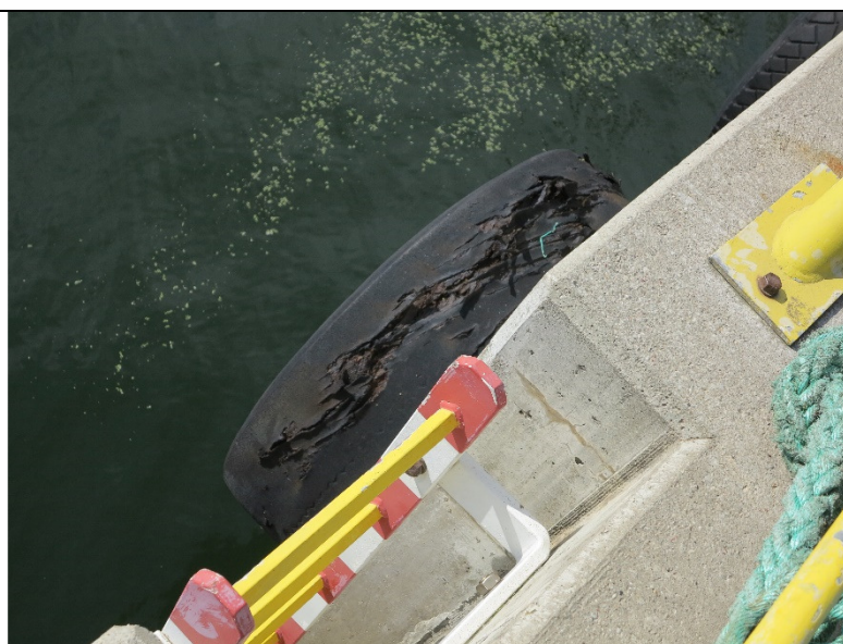
Fot. 11 – widoczne uszkodzenie urządzenia odbojowego (opona staroużyteczna)
