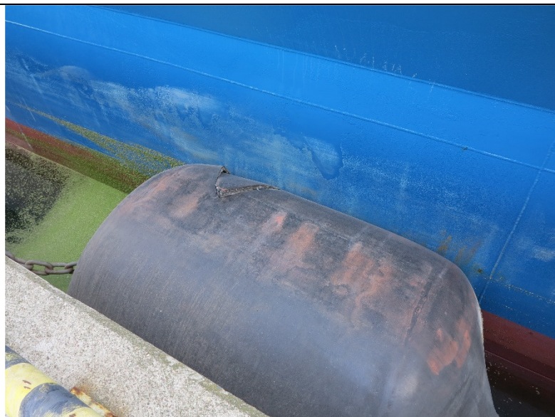
Fot. 22 – odc. 17c-17d uszkodzona odbojnica pneumatyczna
