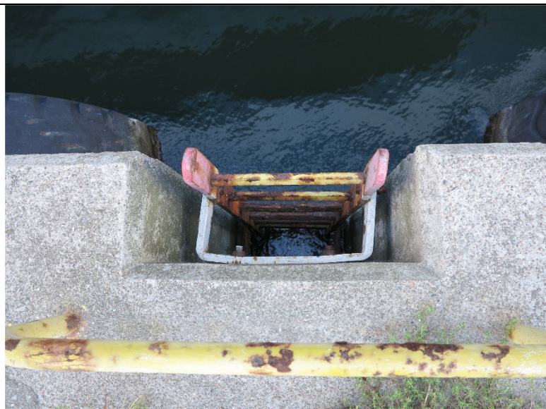
Fot. 19 – drabinka wyjściowa – uszkodzenie drabinki, uszkodzenia powłoki malarskiej i znaczna korozja
