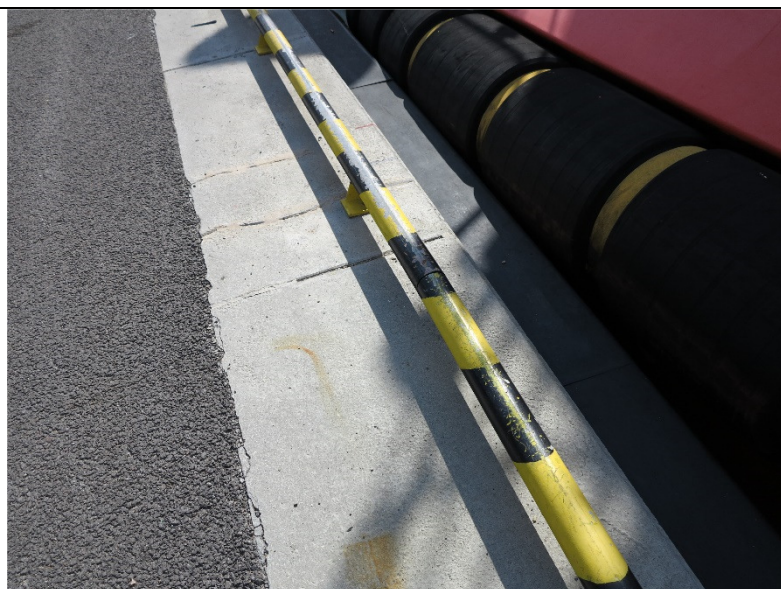
Fot. 9 – stan krawężnika stalowego – widoczne przetarcia powłoki malarskiej
