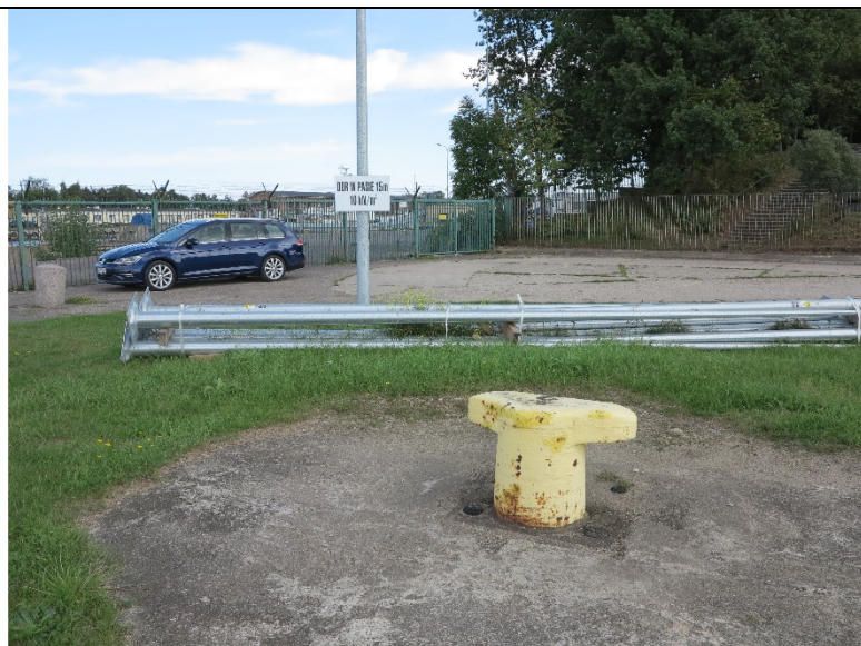
Fot. 3 – pachół cumowniczy drugiej linii – widoczna punktowa korozja
