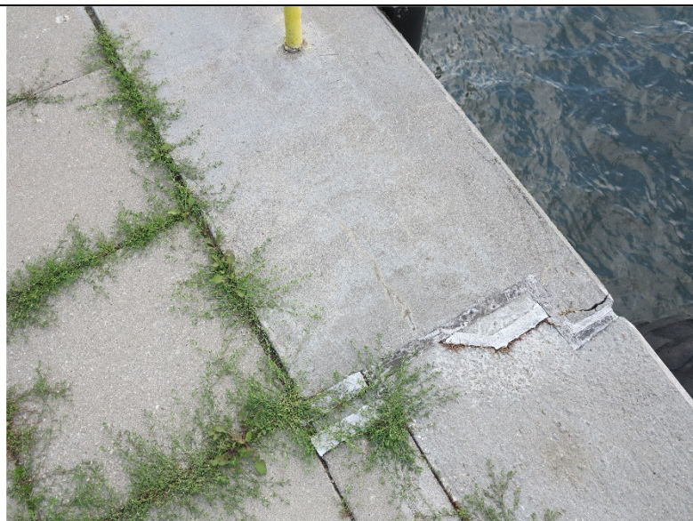
Fot. 4,5 – stan ścieżki cumowniczej nabrzeża, widoczne zarośnięcie roślinnością oraz brak płyty chodnikowej z ubytkiem materiału zasypowego
