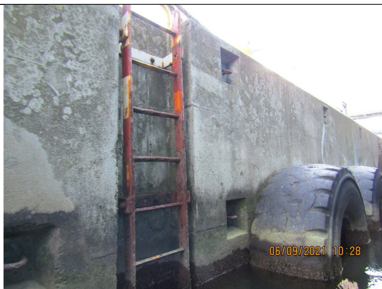
Fot. 29 – stan drabinki wyjściowej urządzeń odbojowych – odc. 17c-17d widok od strony wody
