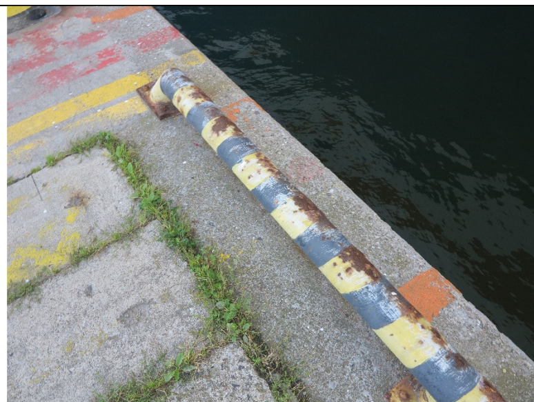
Fot. 18 – krawężnik ochronny stalowy – powierzchniowa znaczna korozja
