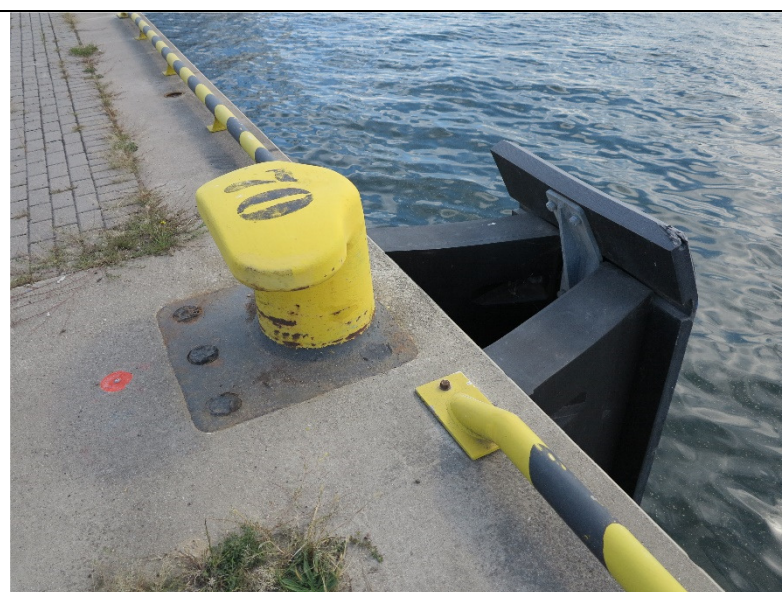
Fot. 17 – pachół cumowniczy 70 – punktowa korozja, odbojnica systemowa – stan dobry; krawężnik ochronny stalowy – lokalne ubytki powłoki malarskiej
