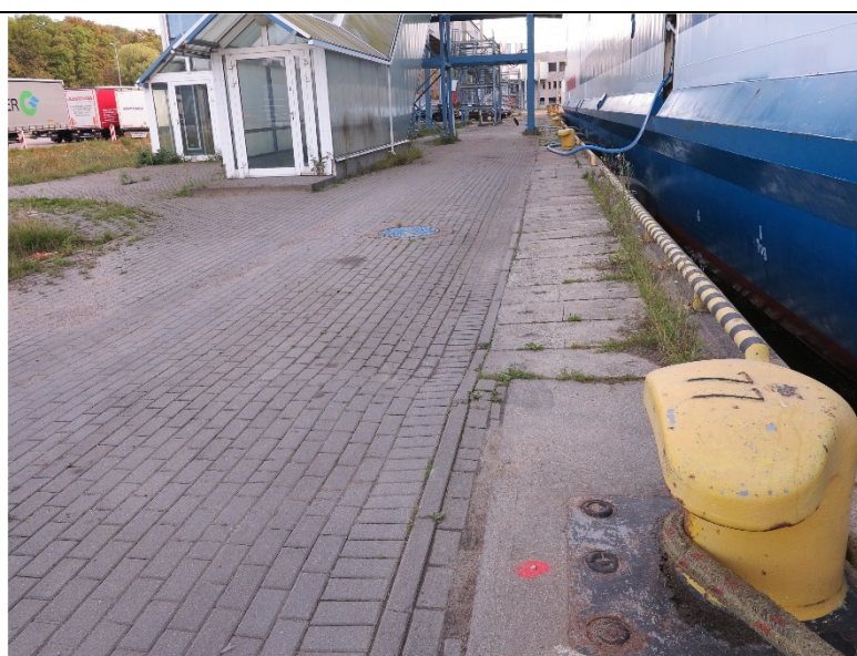
Fot. 20 – nierówności w nawierzchni nabrzeża
