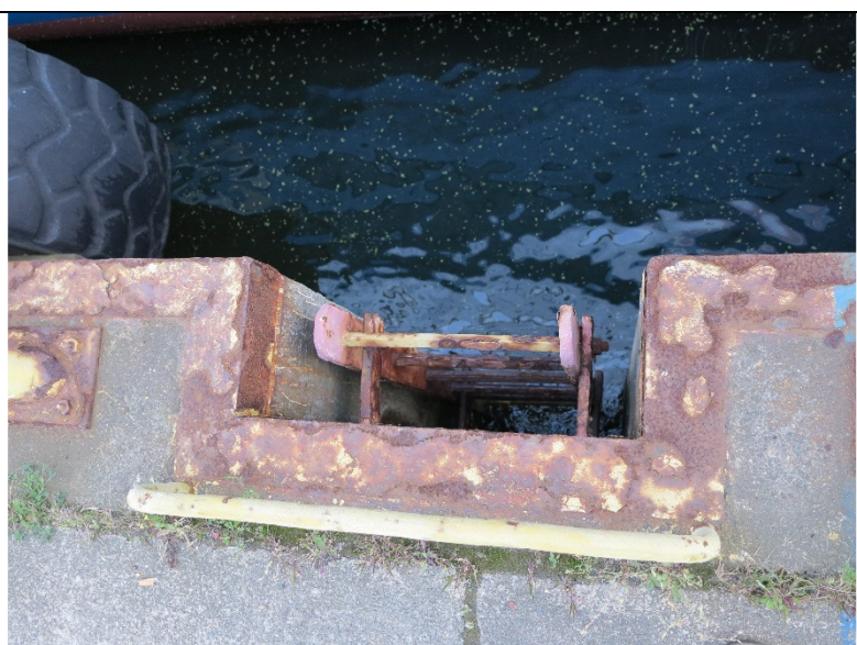
Fot. 23 – znaczna korozja drabinki wyjściowej oraz kątownika ochronnego
