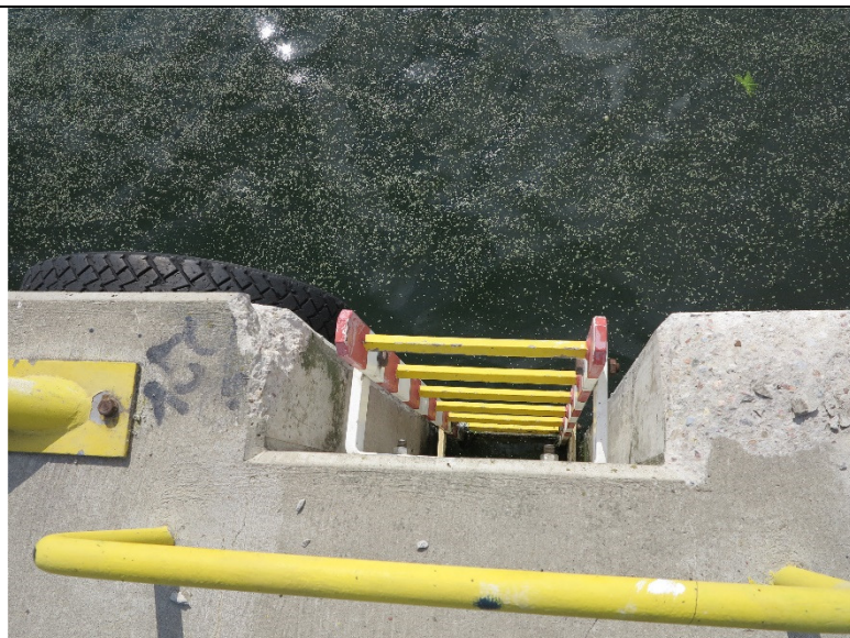
Fot. 13,14 – widoczne lokalne uszkodzenia betonu oczepu
