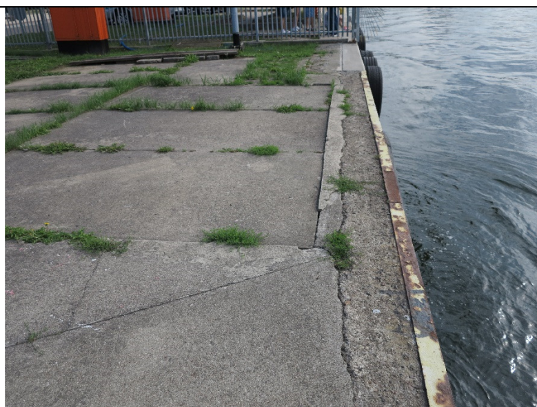
Fot. 24 – stan nawierzchni odcinka 17f-18 nabrzeża – widoczne zarośnięcie roślinnością oraz liczne spękania betonu
