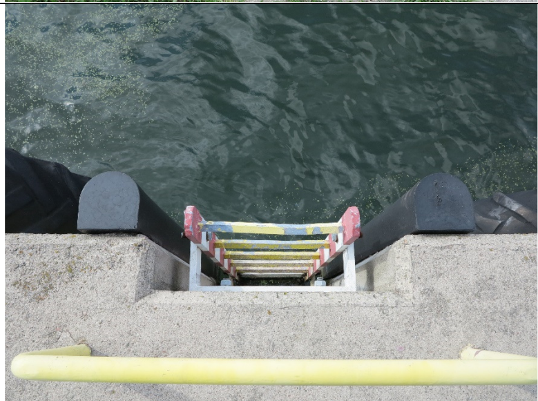
Fot. 6 – stan drabinki wyjściowej – nieznaczne odpryski powłoki malarskiej
